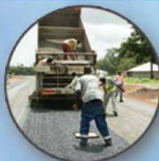
Aménagement de chaussées
